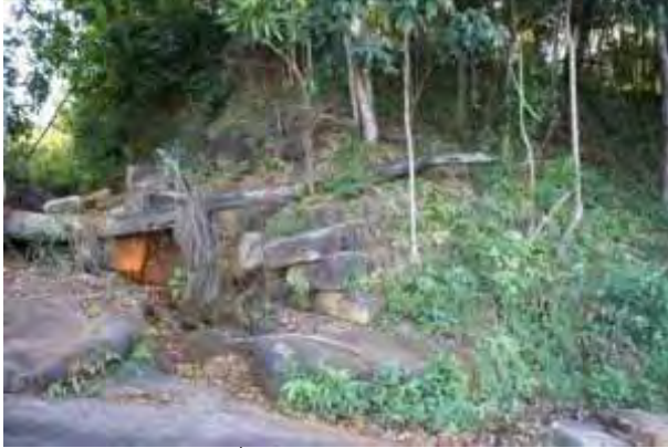
ร่องรอยของเขื่อนหินทรายใกล้บริเวณสระตราว
